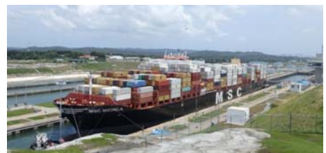
新パナマ運河(第3閘門) 2016年6月供用開始
