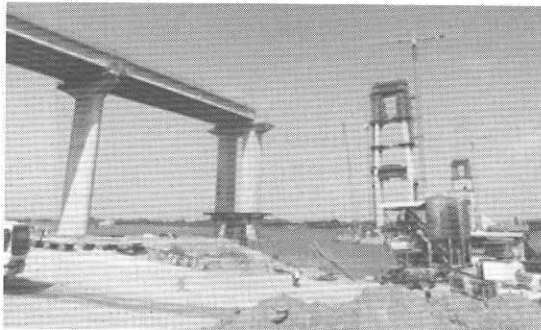
写真2 メコン川カンボジア国道1号線ネアックルン橋建設現場
